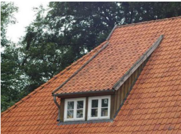
Abb. 19 Beispiel Schleppdachgaube mit seitlicher Holzverschalung
