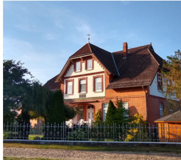
Abb. 28 Beispiel Wohnhaus mit Putzfassade im Obergeschoss und Ziergesimsen
