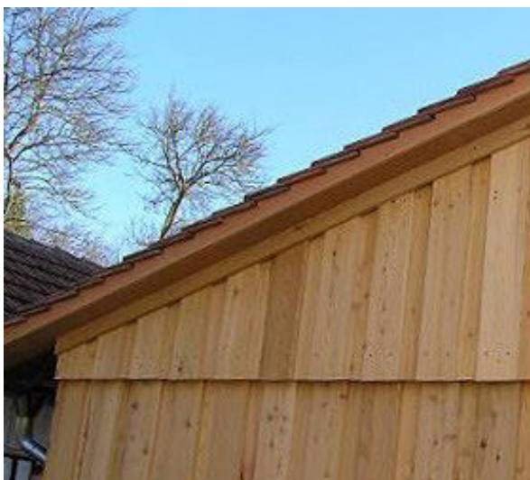
Abb. 22 Beispiel Dachabschluss mit Zahnleiste
