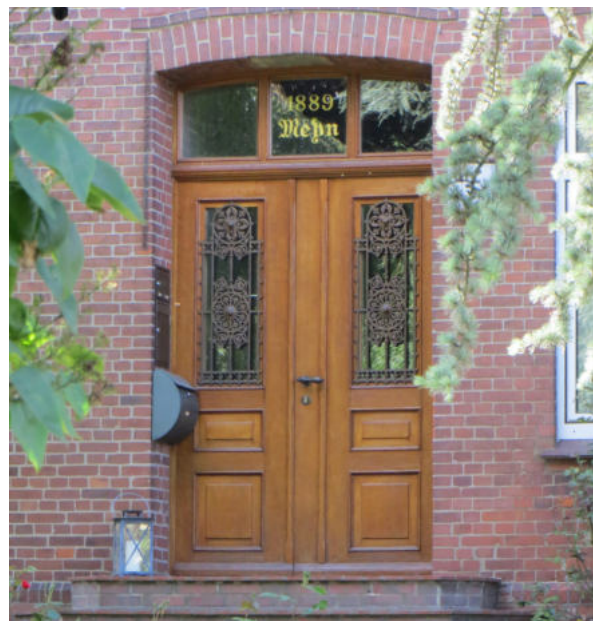
Abb. 35 Beispiel historische Eingangstür
