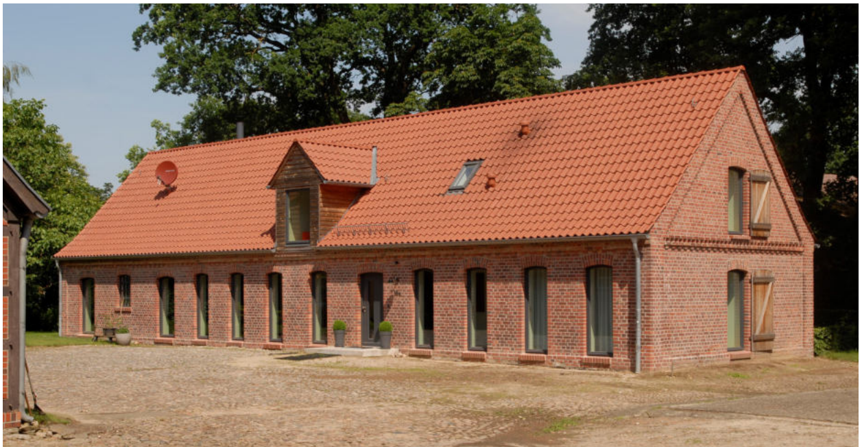
Abb. 37 Beispiel einer dorfgerechten Umgestaltung und Belichtung eines Stallnebengebäudes
