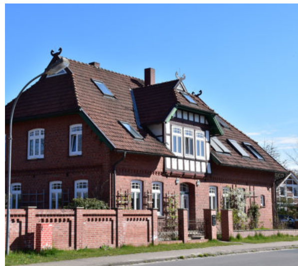
Abb. 29 Wohnhaus mit gemauertem Erdgeschoss und verziertem und verputzten Fachwerk
