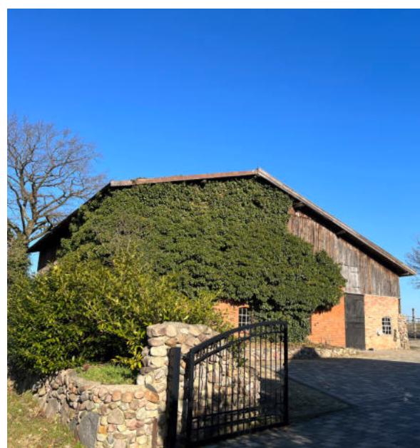
Abb. 31 Beispiel üppige Fassadenbegrünung einer Scheune
