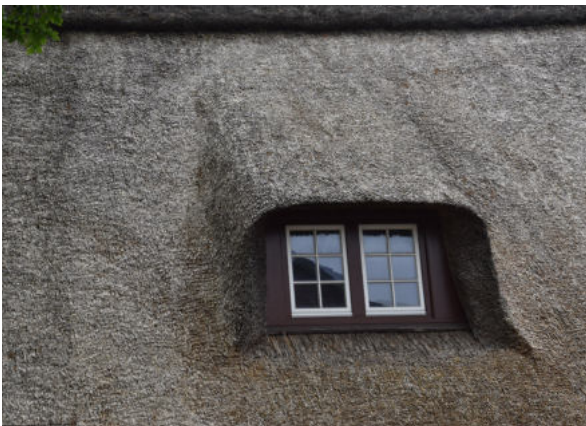
Abb. 20 Beispiel Fledermausgaube im Reetdach
