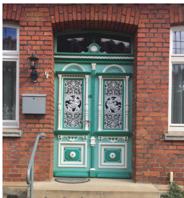
Abb. 36 Beispiel historische Eingangstür
