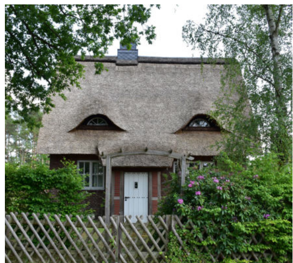
Abb. 8 Reetdach der Region
