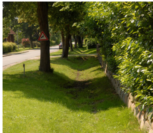
Abb. 45 Beispiel innerörtliche Versickerungsmulde im Straßenraum
