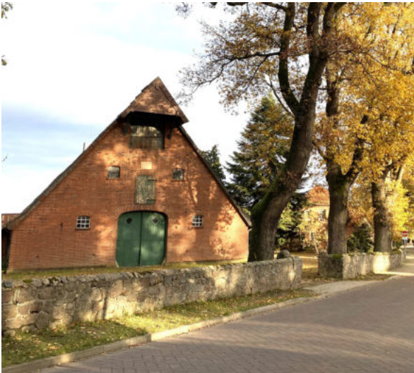
Abb. 13 Wohnwirtschaftsgebäude mit Krandach im Giebel
