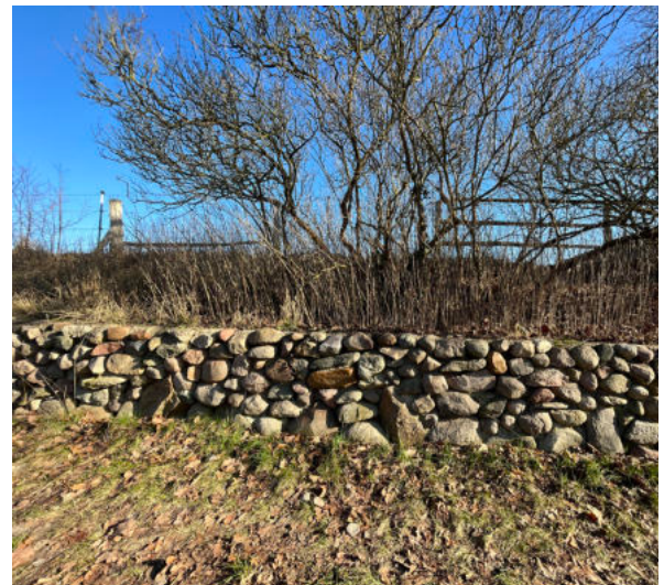
Abb. 43 Beispiel Einfriedung aus Naturstein, trocken aufgesetzt
