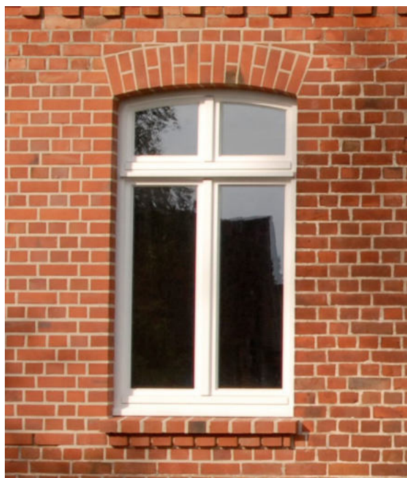
Abb. 33 Beispiel Zweiflügeliges weißes Fenster mit Oberlicht (um 1900)
