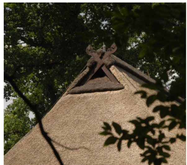
Abb. 24 Beispiel eines Eulenlochs
