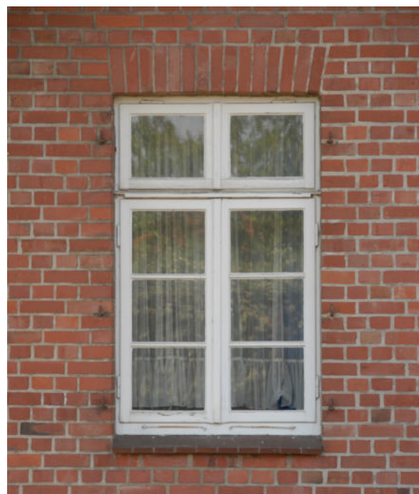
Abb. 34 Beispiel Fenster mit einfacher Sohlbank
