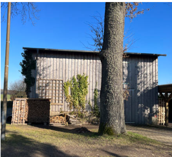
Abb. 27 Beispiel für Holzverschalung am Nebengebäude
