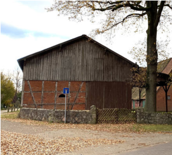
Abb. 26 Holzverschalung am Nebengebäude
