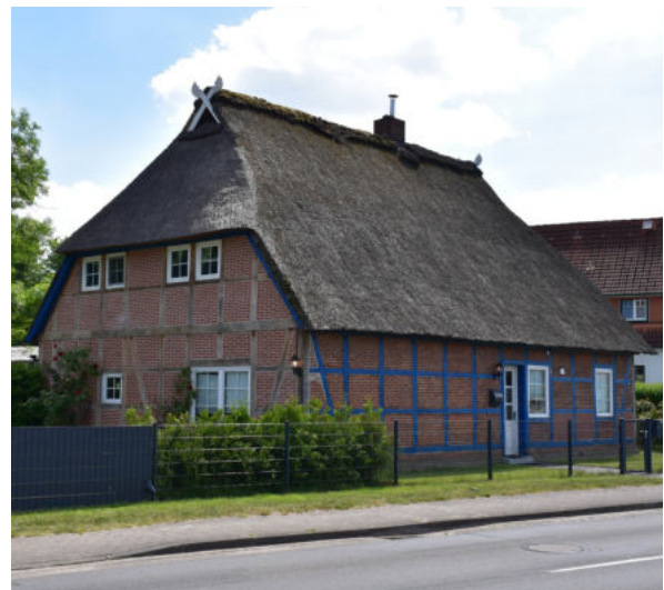
Abb. 7 Reetdach der Region
