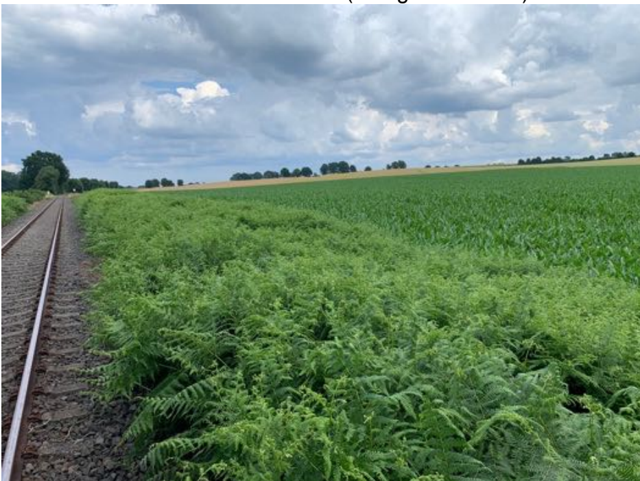
Abb. 4: Bahndamm im Abschnitt A (Plangebiet rechts)
