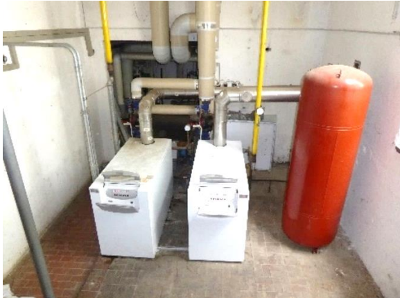
Gas-Brennwert-Kessel & Druckausgleichsgefäß
