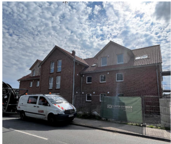
Abb. 81 Neubau Wohn- und Gewerberäume in Garstedt
