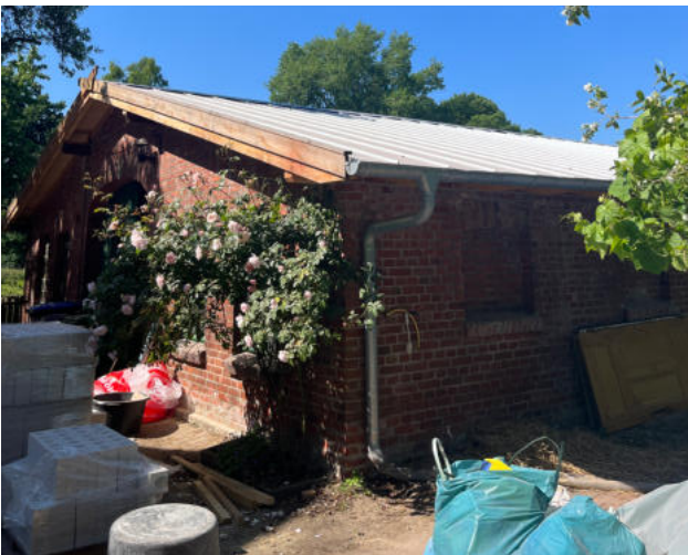
Abb. 105 Beispiel Umnutzung Remise zu Gemeinschaftswohnräumen
