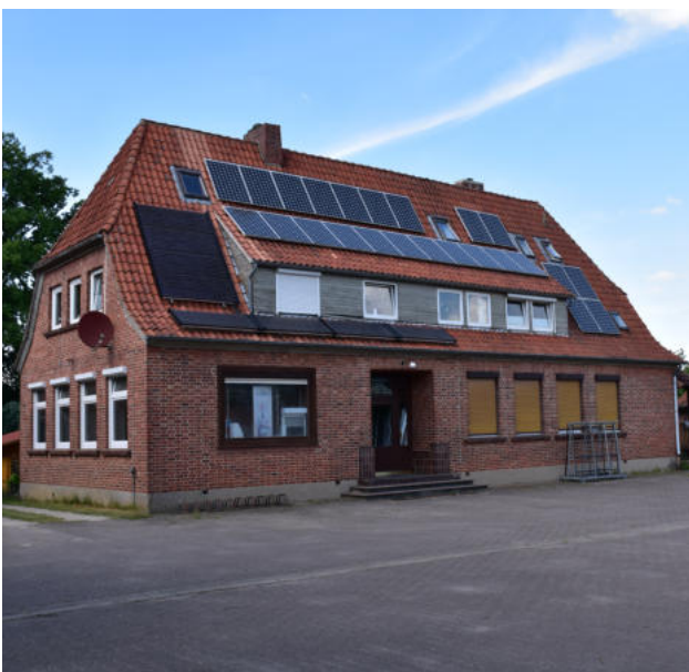
Abb. 55 Solaranlagen in Toppenstedt
