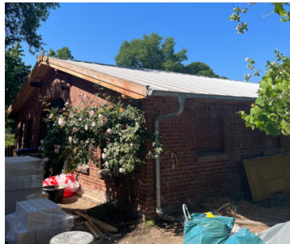
Abb. 128 Beispiel Umnutzung Remise zu Gemeinschaftswohnräumen
