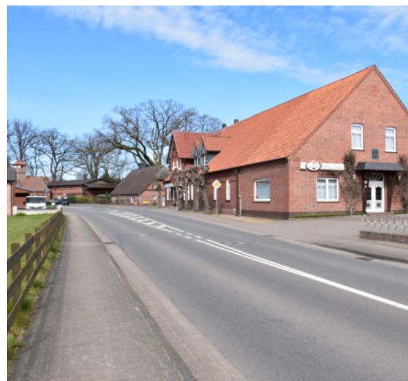
Abb. 53 Fehlende Durchgrünung in der Hauptstraße in Toppenstedt
